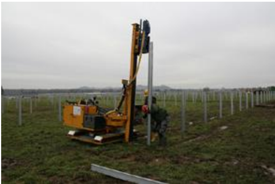
Zdjęcie 2 Montaż profili za pomocą kafara.
