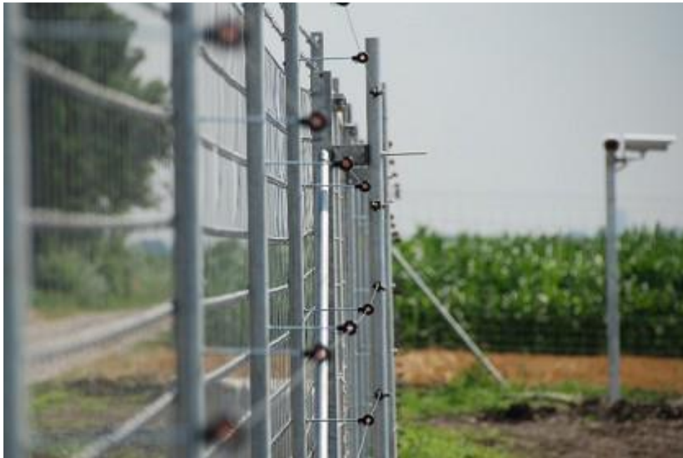
Zdjęcie 8 Przykładowe ogrodzenie farmy fotowoltaicznej.
