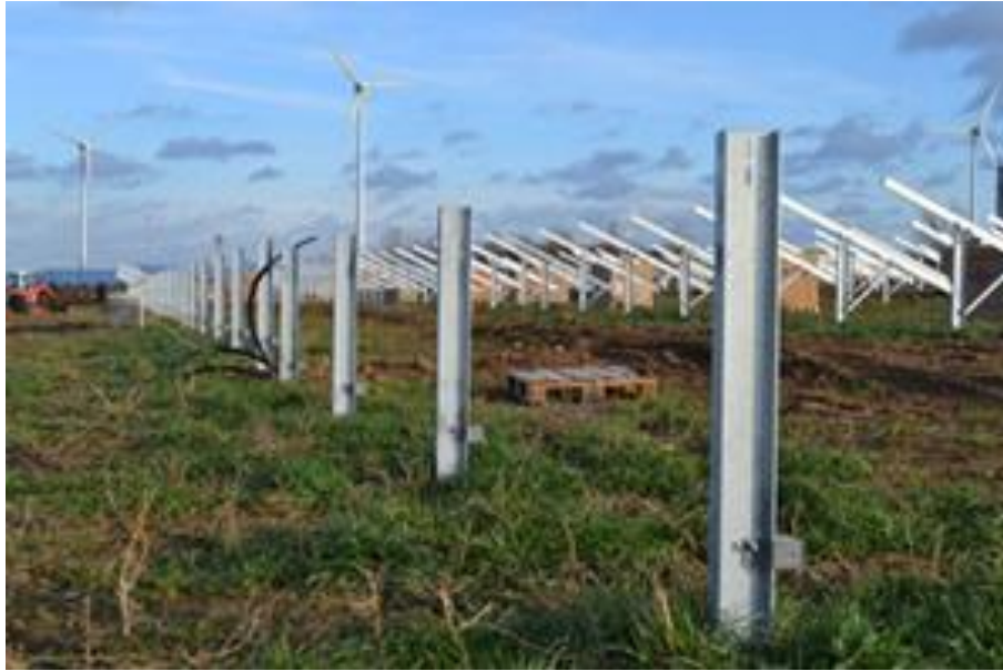
Zdjęcie 1 Profile metalowe: podstawowy element konstrukcji.
