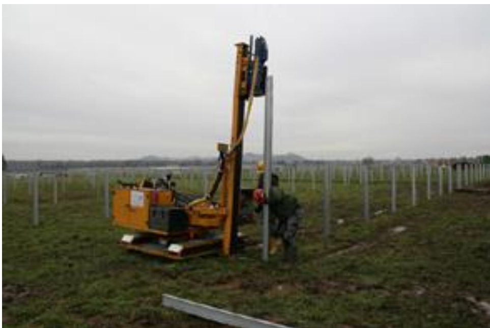
Zdjęcie 2 Montaż profili za pomocą kafara.
