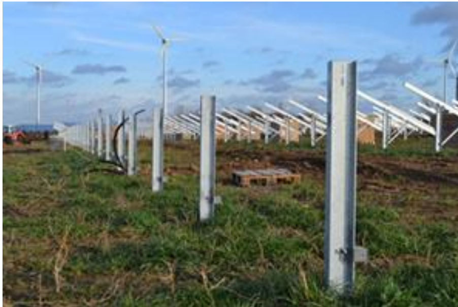
Zdjęcie 1 Profile metalowe: podstawowy element konstrukcji.
