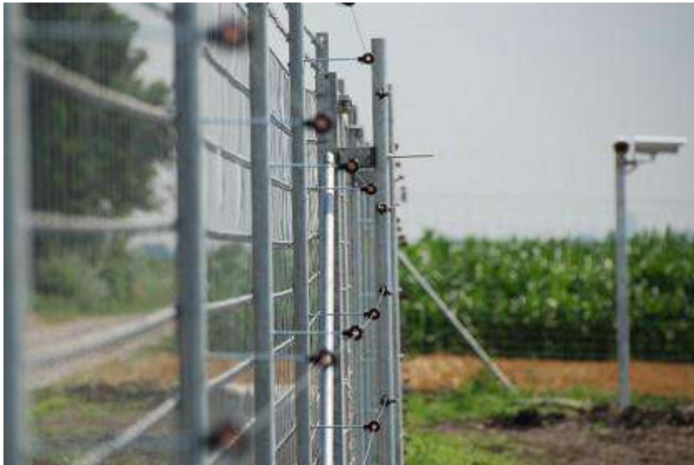
Zdjęcie 8 Przykładowe ogrodzenie farmy fotowoltaicznej.
