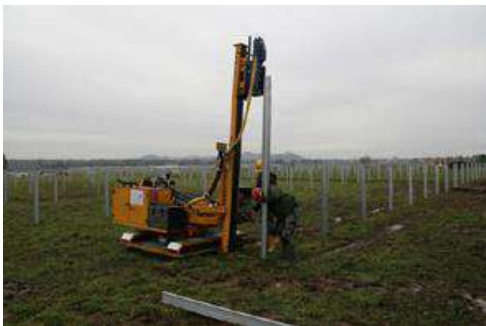
Zdjęcie 2 Montaż profili za pomocą kafara.
