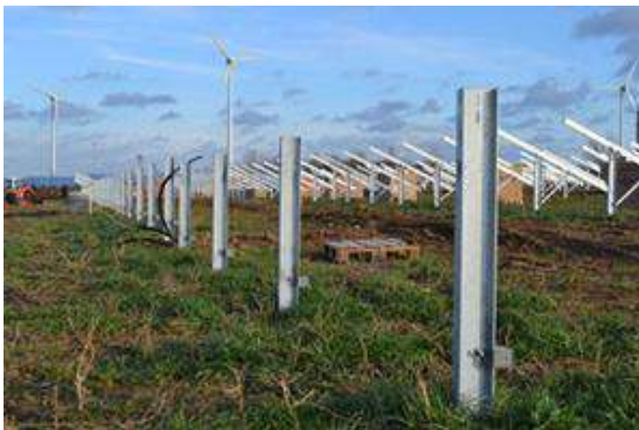
Zdjęcie 1 Profile metalowe: podstawowy element konstrukcji.
