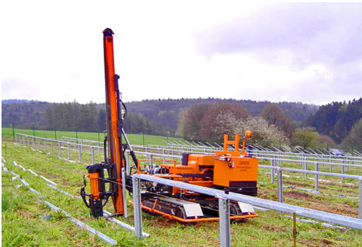
Fot. 1. Maszyna wciskająca konstrukcje stalowe w grunt. Zdjęcie www.projekt-solartechnik.pl .
