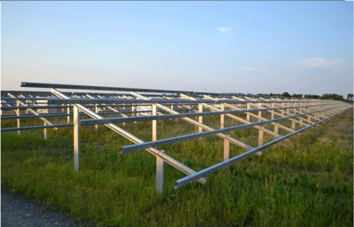
Fot. 2. Stalowa konstrukcja gotowa do montażu paneli fotowoltaicznych. Zdjęcie www.projekt-solartechnik.pl .
