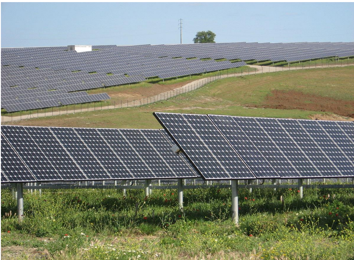
Fot. 3. Pracująca farma fotowoltaiczna z terenami zielonymi, ażurowym ogrodzeniem i stacją kontenerową (lewy górny róg fotografii).
